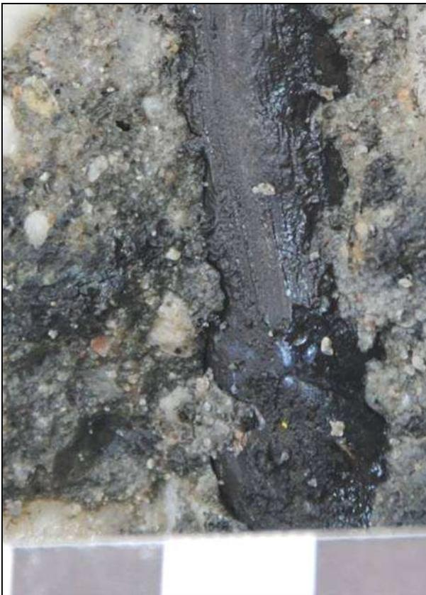
Bild 12: Angesetzter Betonstahl im Rissbereich
