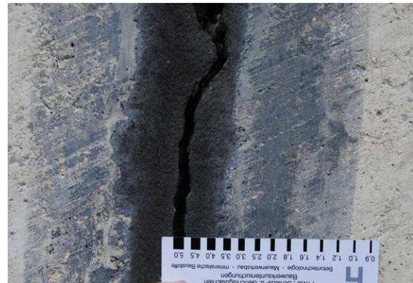
Bild 13: versprödete und gerissene Dichtungsmasse im Bereich einer vertikalen Dehnfuge
