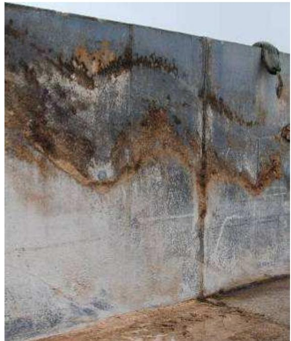
Bild 7: Betoninnenwand nach Entnahme Silostock mit von oben nach unten zunehmenden Säureangriffsgraden, vergleiche Bild 8
