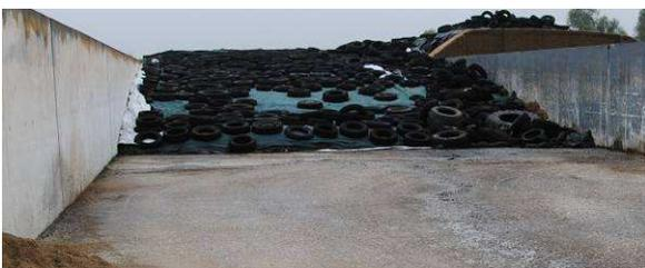
Bild 1: typische Fahrsilo mit senkrechten Betonwänden und halb entnommenen Silostock
