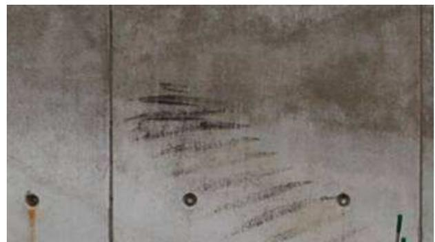
Bild 15: Abriebspuren an Betonwandung
