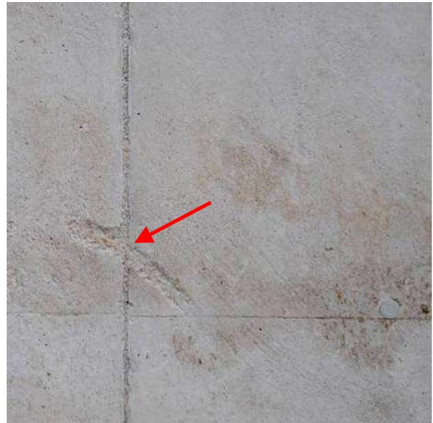
Bild 14: Kerbe in Betonwandung verursacht durch Entladeschaufel
