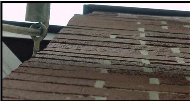
Bild 7: Ausknicken der Vorschale aufgrund Quelldehnung der verarbeiteten Vormauersteine
