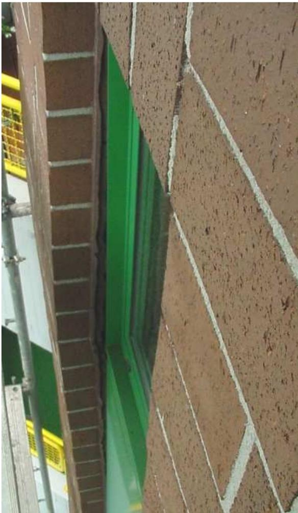
Bild 11: deutlich sichtbare Ausmitte der Vorschale
