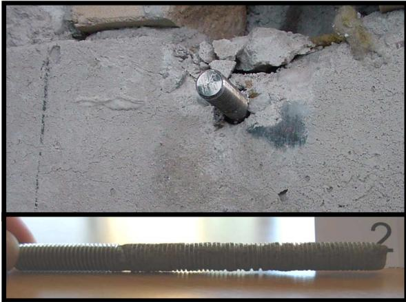
Bild 10: oben: Ausbruch über Ankerdorn der Konsole
