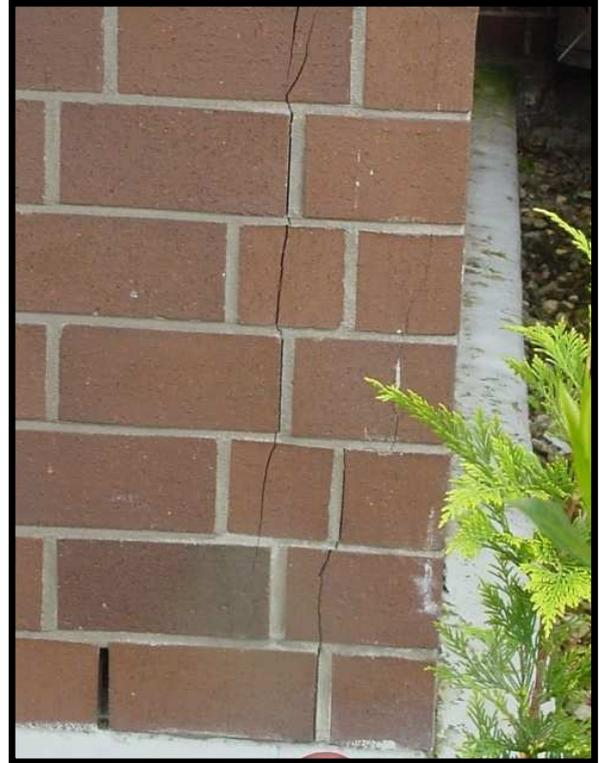
Bild 8: Spannungsrisse am Fuß der Mauerschale
